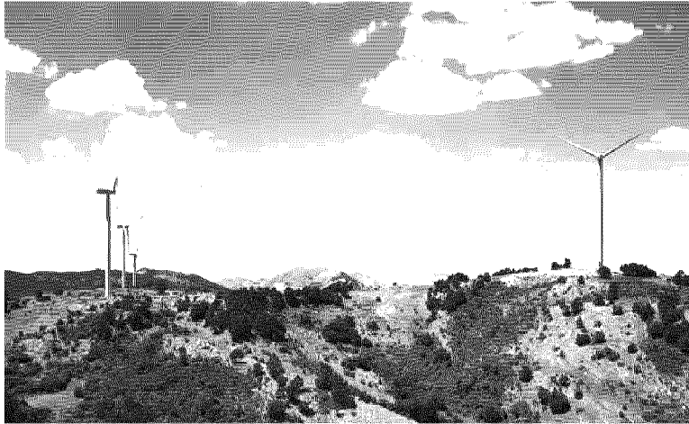
In Basilicata. Parco eolico Brienza da 18 MW
