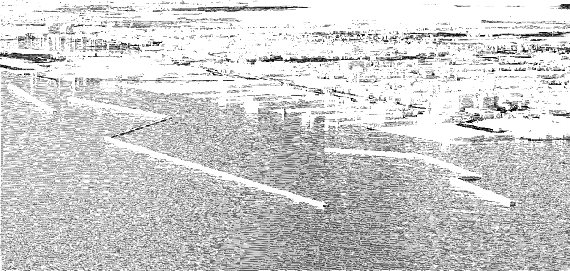
L'investimento chiave. La Diga Foranea di Genova è l'opera centrale per il futuro della città
